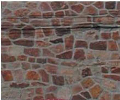
Moëllons avec joints blanchis
