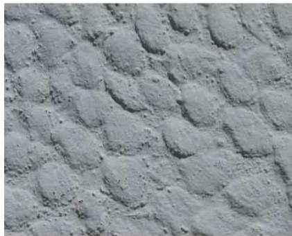
Enduits réalisés «à la cuillère»
